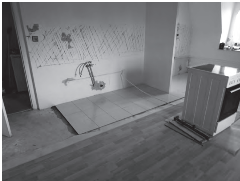
Fotografie z rekonstrukce nových prostor teplické obce. (Foto P. Jirgl.)
