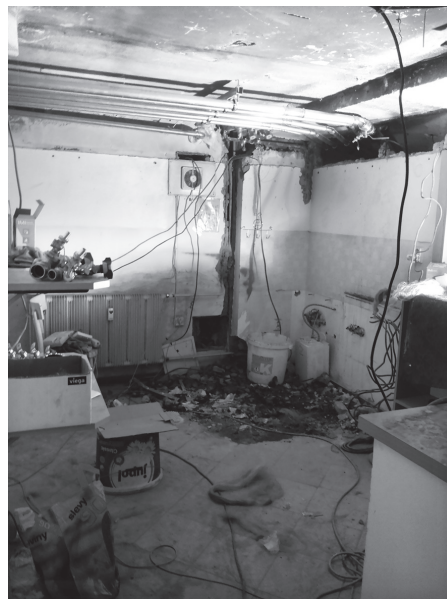
Rekonstrukcí projde také kuchyňka.
