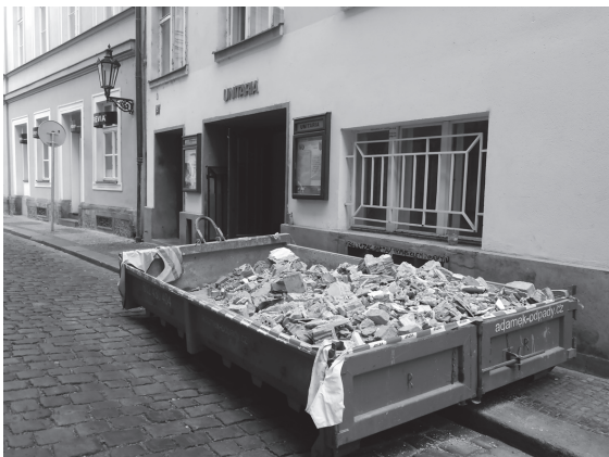
Prvního července začaly přípravné práce spojené s plánovanou rekonstrukcí našich sálů. (Všechna foto KLK.)
