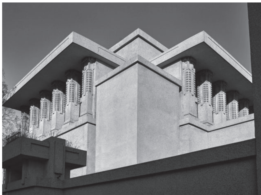
Exteriér budovy Unity Temple v Chicagu. (Foto KLK.)
