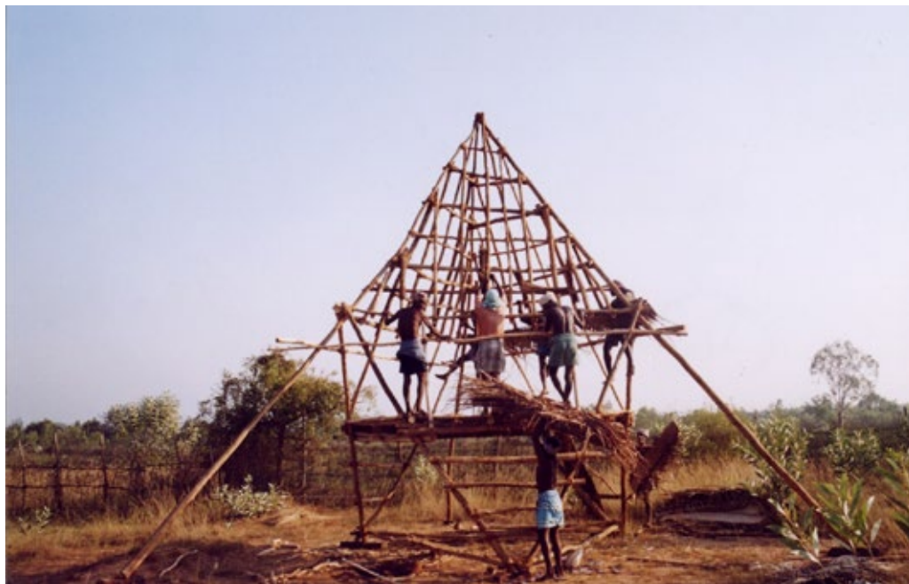
Konstrukce obytné chaty, květen 2004. (Foto © sadhanaforest.org.)
