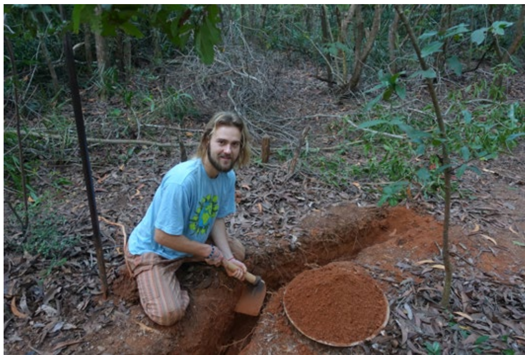
Hloubení kanálů pro zadržování dešťové vody. (Fotografie z archivu Sebastiana Praxe.)
