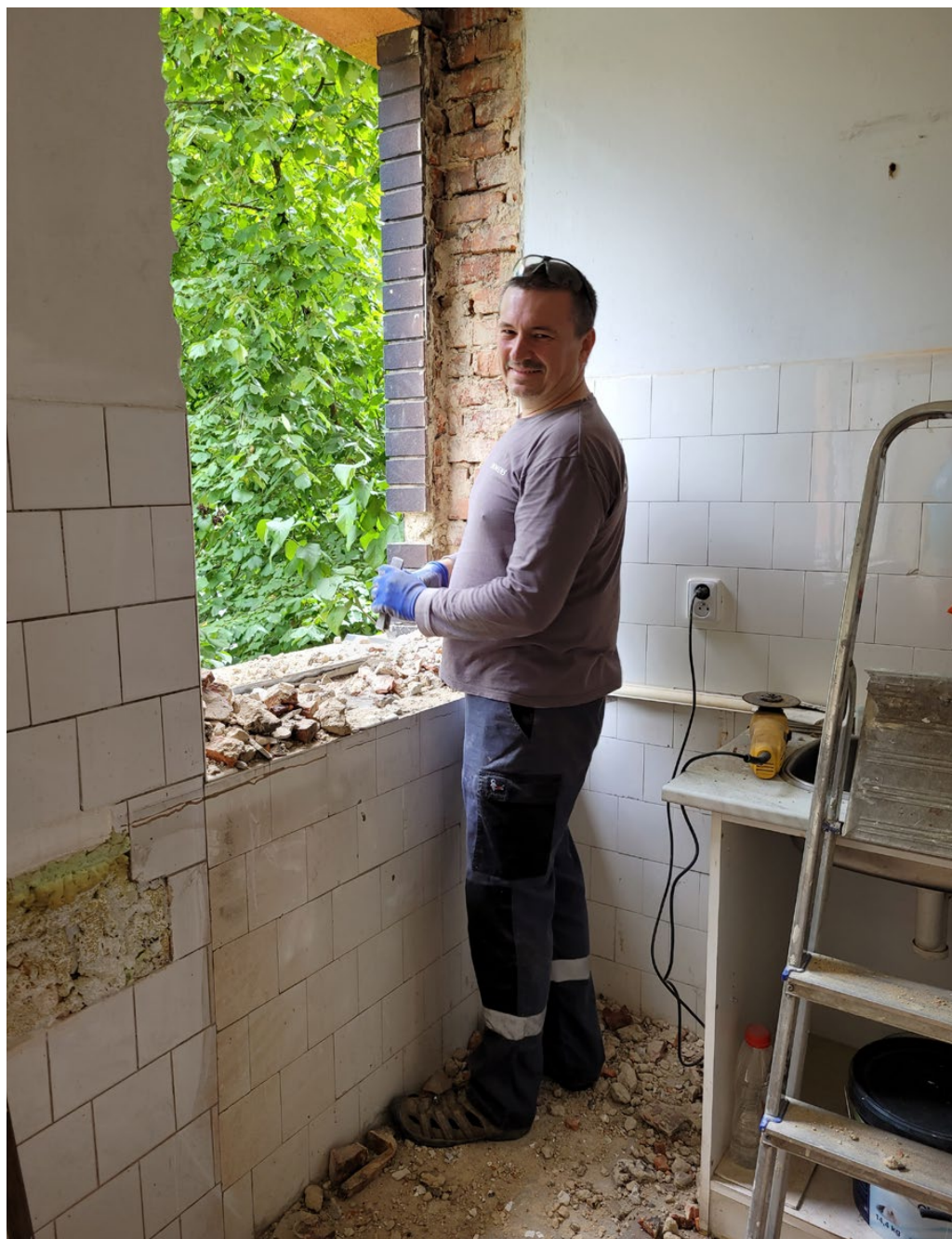
Výměna oken v kuchyni.
