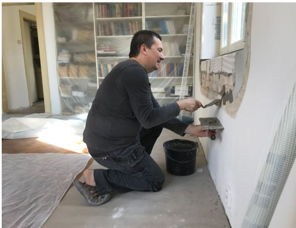
Zednické začišťovací práce.
