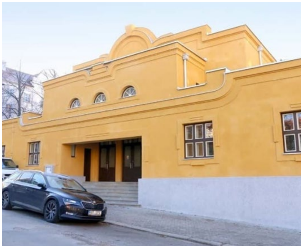
Budova Žižkostela. (Všechny fotografie pocházejí z archivu Žižkostela.)
