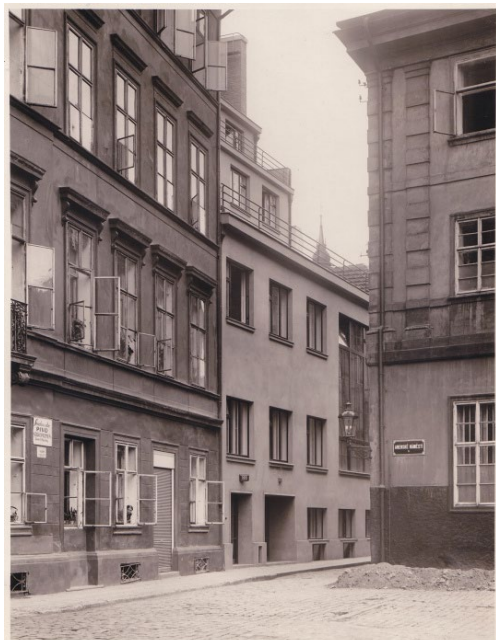
Výstavba multifunkčního domu se třemi sály v Anenské přinesla NSČU v době hospodářské krize mnoho vleklých finančních problémů. (Všechny fotografie pochází z archivu NSČU.)
